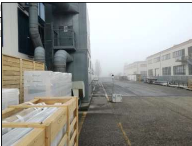
Fig. 3.1.c – aspiratore sul lato NW dello stabilimento
