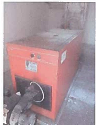
fig. 5 – Generatore e bruciatore
