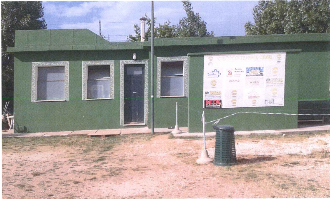
Foto 1 – Locale spogliatoi ( vista frontale )
