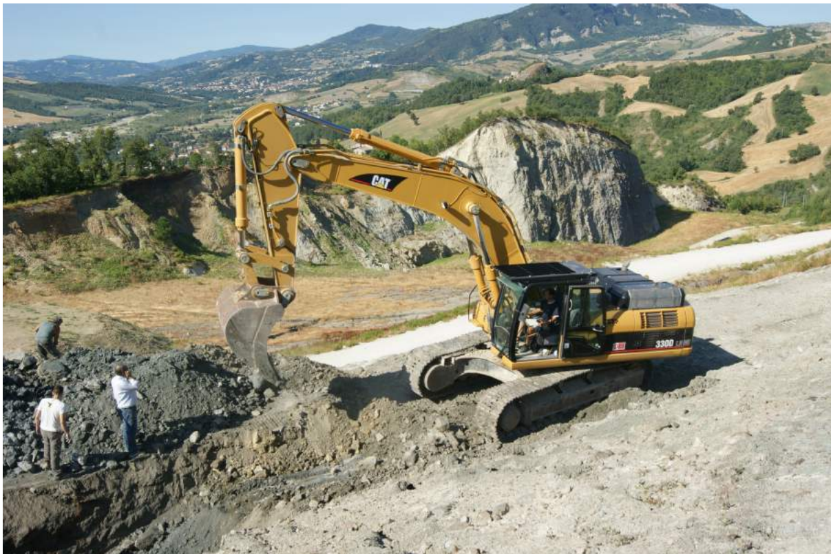
Fig. 5. Lo sbancamento di una porzione della Cava ha permesso di verificare nel dettaglio la successione stratigrafica che ha preservato il Mosasauro.
