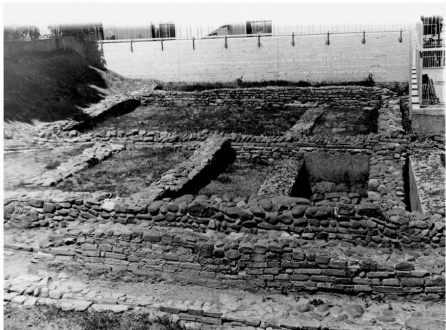
Fig. 13. I nuovi ambienti seguito del riempimento dalla vasca in opus spicatum .
